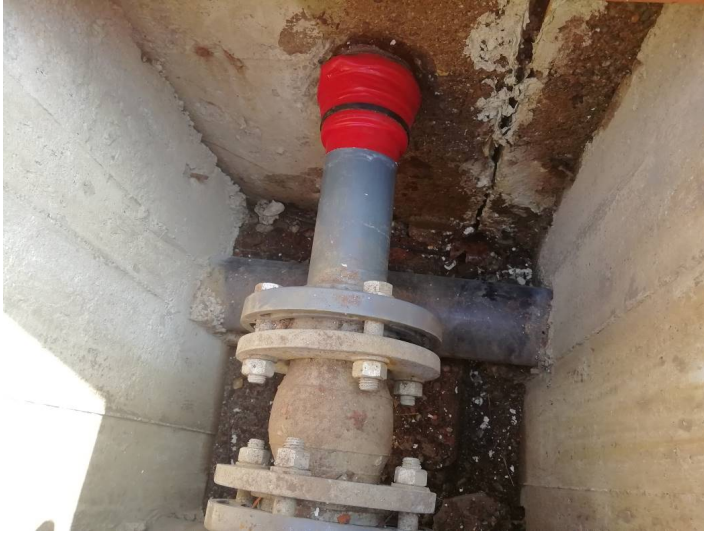
BOCCHETTE DI MANDATA - LATO POZZETTI PIANO VASCA
